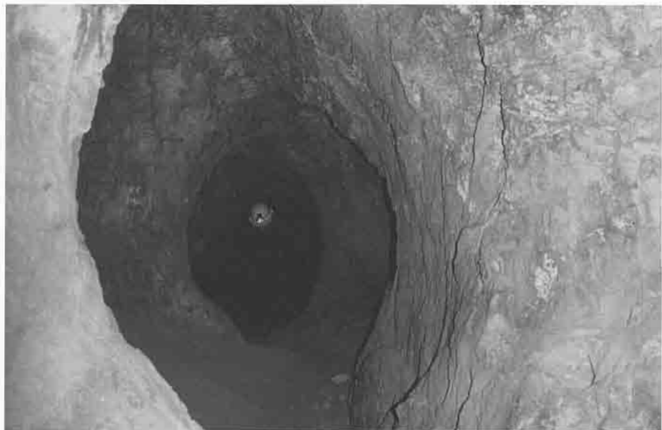
◀ Vista del Conducto Principal de la Galería Superior
